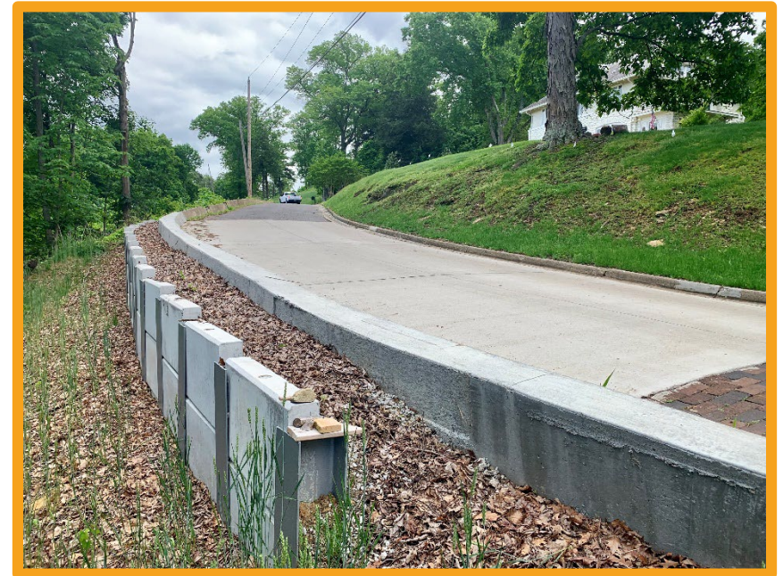
Road slip repair on N. Altamont Rd
